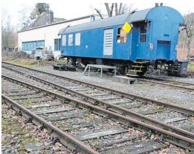
Noch auf dem Abstellgleis: Die Almetalbahn, hier der Bahnhof Ringelstein, verbindet Paderborn und Brilon über Büren.
