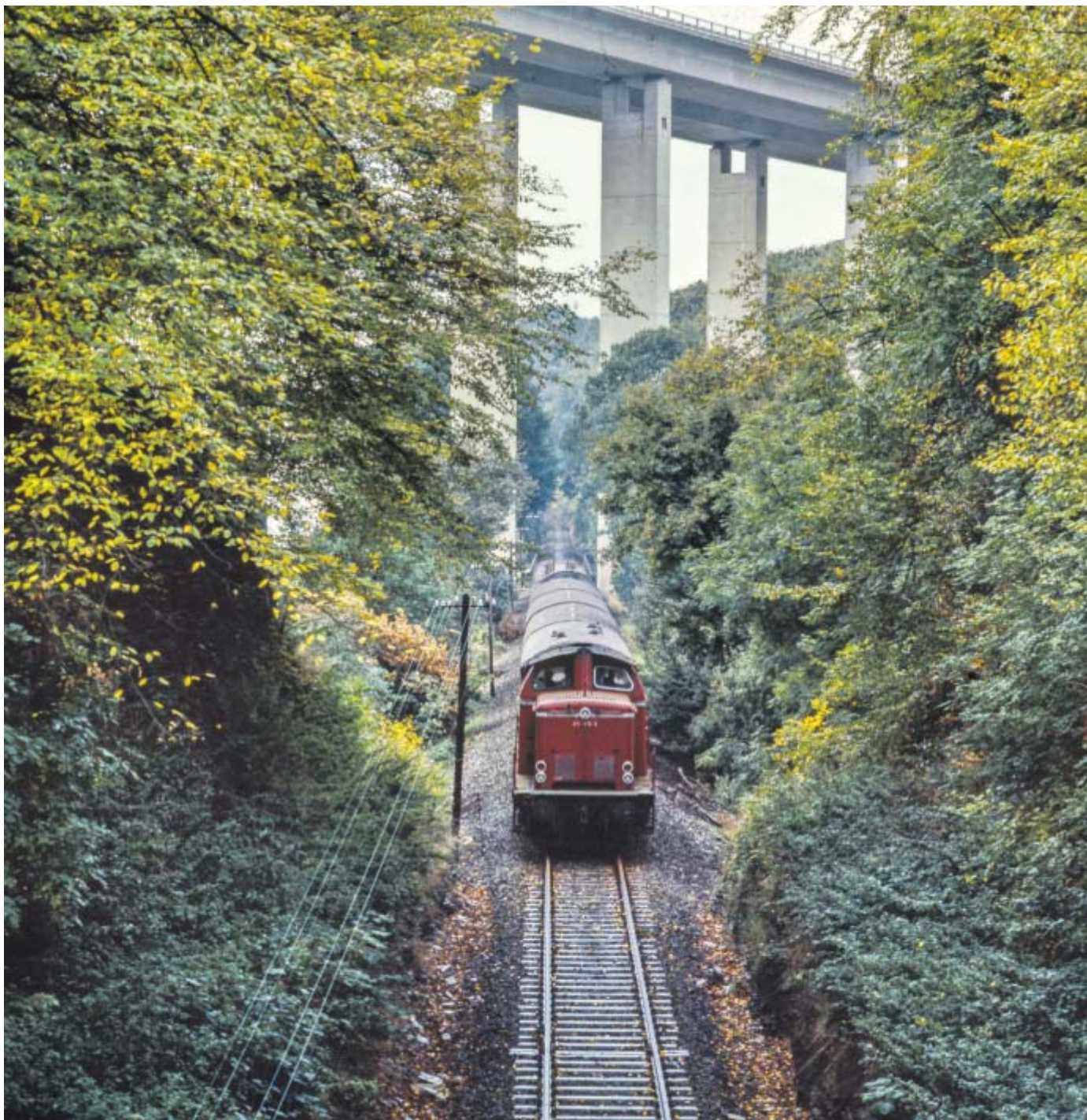
Bild aus vergangenen Zeiten: Die Almetalbahn unterhalb der A 44.
