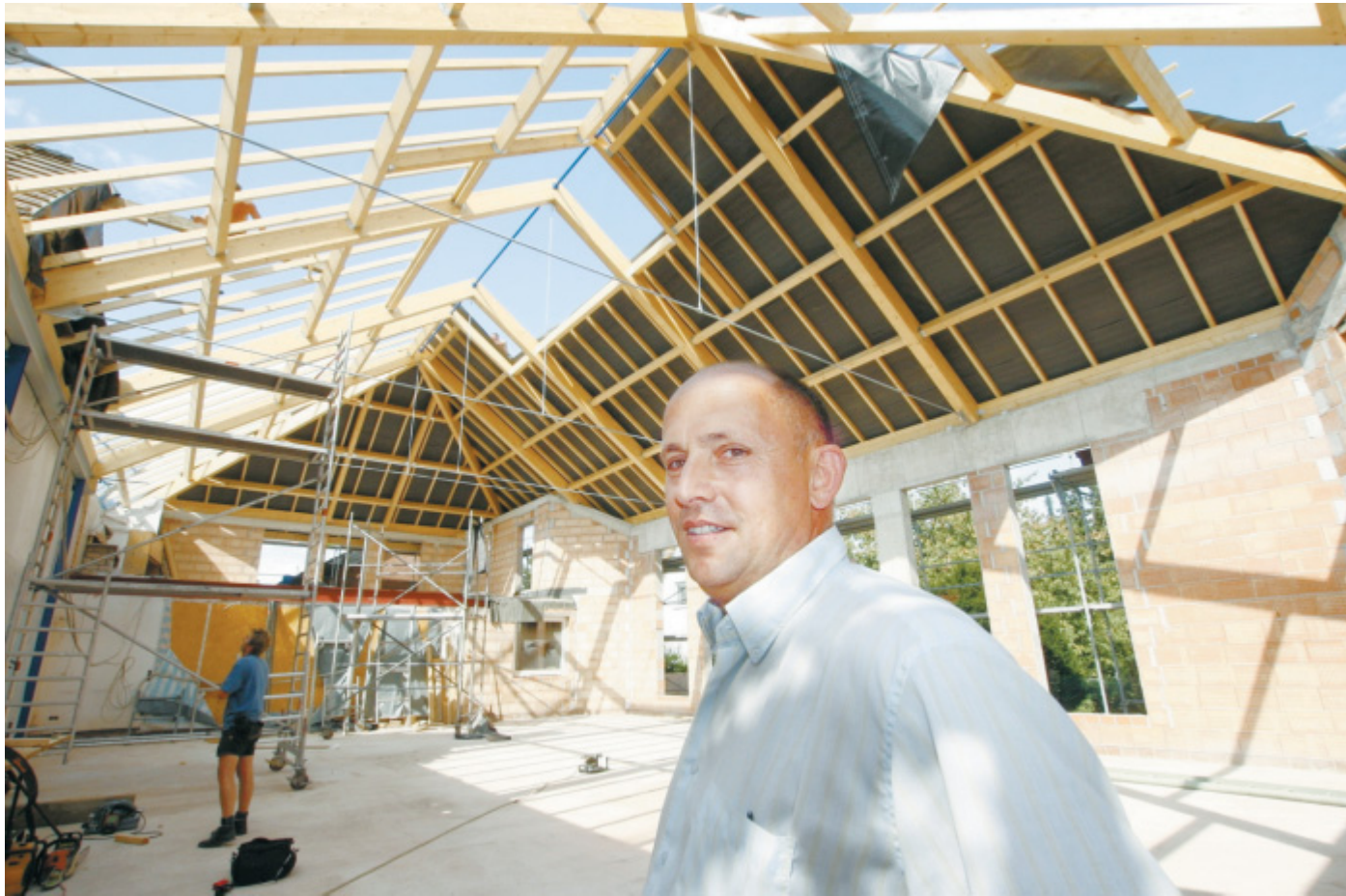
Im Haus des Herrn: Pfarrer Reinhard Ernst Bogdan im neuen Kirchraum, an dessen Ende eine Empore entsteht. Das Dach wird zum Richtfest mit Planen bedeckt, während Zimmermeister Udo Teichmann per Fernsteuerung den Kran lenkt.
